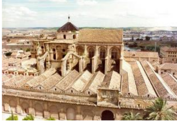
صورة رقم (9) توضح الاسقف الجما لونية في سقف المسجد
